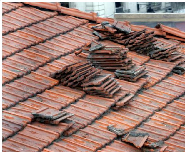
Constitue par exemple une mesure conservatoire, la remise en état d'une toiture destinée à empêcher la chute de tuiles. Archives V.GENIN.
