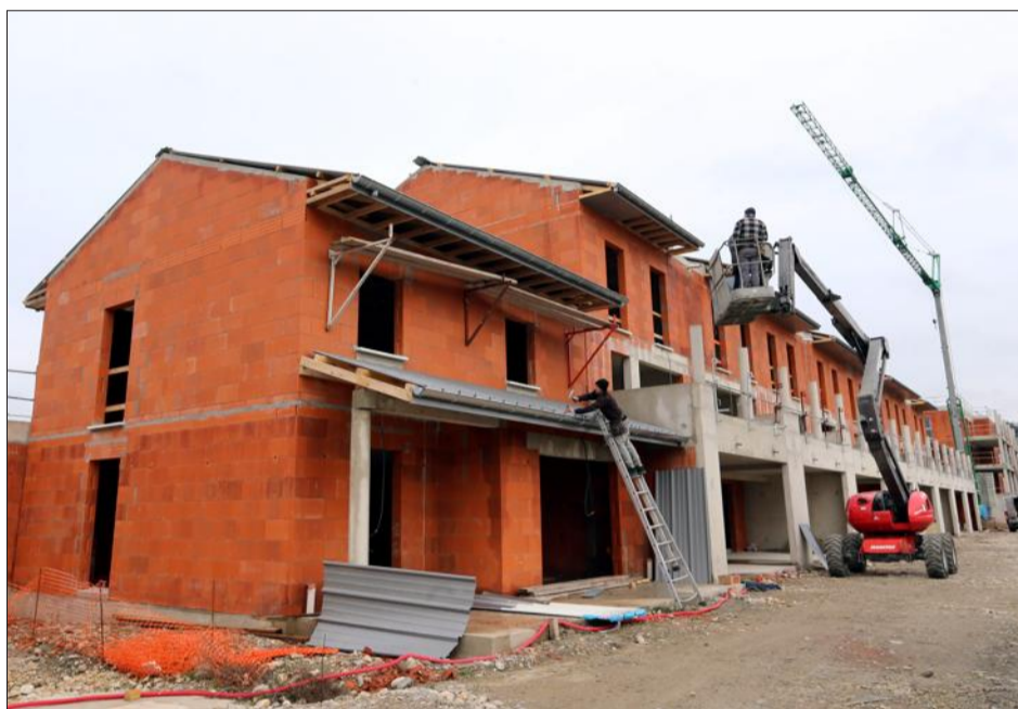
La construction de nouveaux ensembles de logements, à Champ-Fleuri, en face des Abattoirs à Bourgoin-Jallieu, avance à grands pas. Photo Le DL/Jean-François SOUCHET
